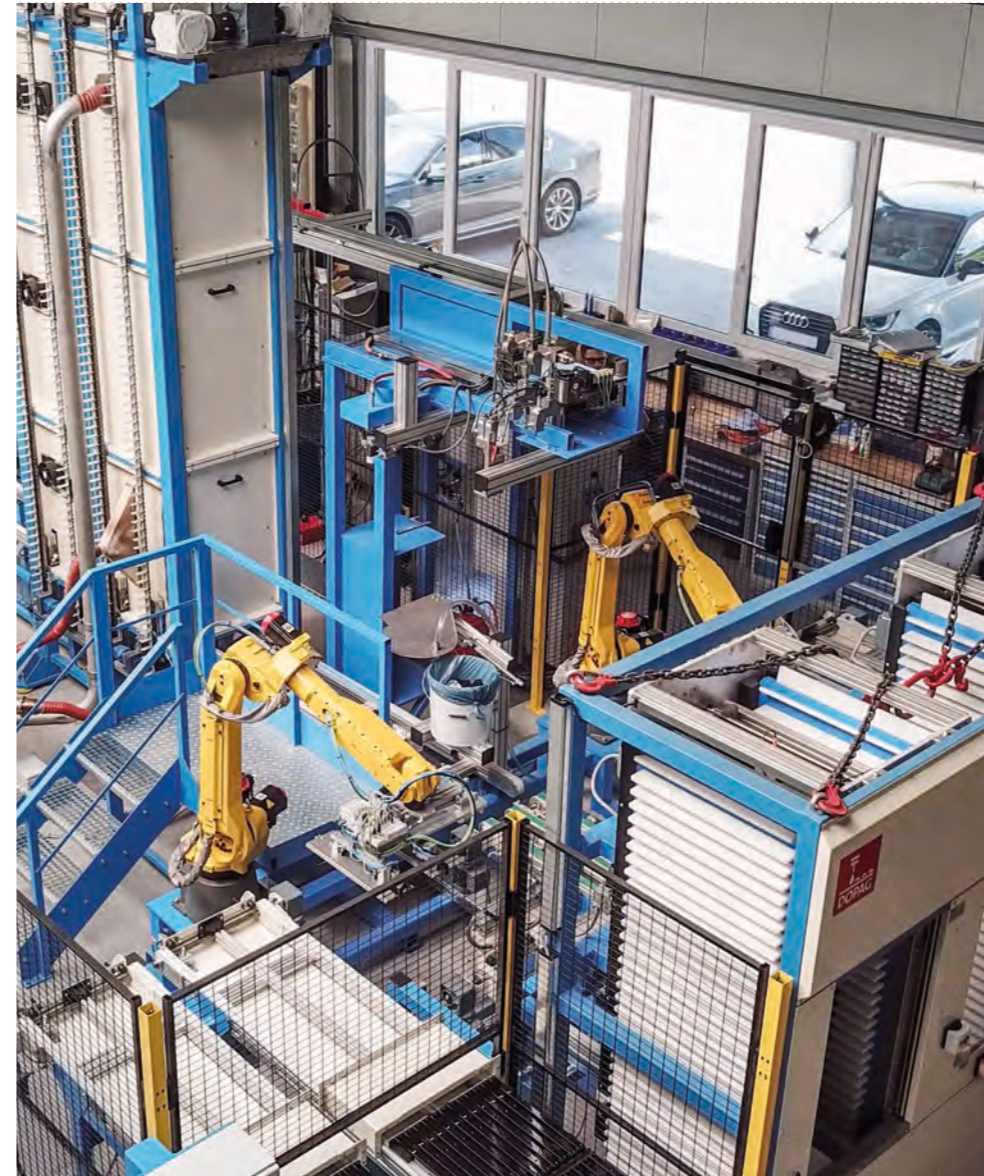
Individuelle Dosieranlage für den Haushaltsgerätehersteller Amica: Gefügt werden Komponenten für Backofentüren, inkl. Vorbehandlung mit dem Pyrosil-Verfahren und Nachbehandlung in einem Aushärte-Puffer.
